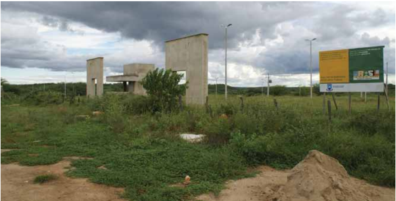
No local em que deverá ser uma Central de Aulas, por enquanto, apenas um pórtico foi instalado.
