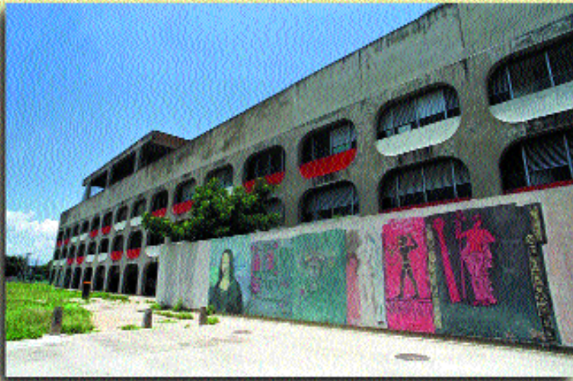
Imagens clássicas servem de tapume a uma obra pública (escola inacabada), abandonada e destruída pelo tempo.
